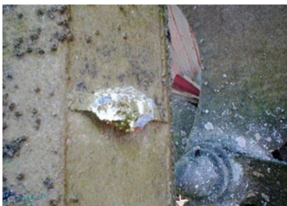
Ovako izgleda potpuno "istrošena" anoda
